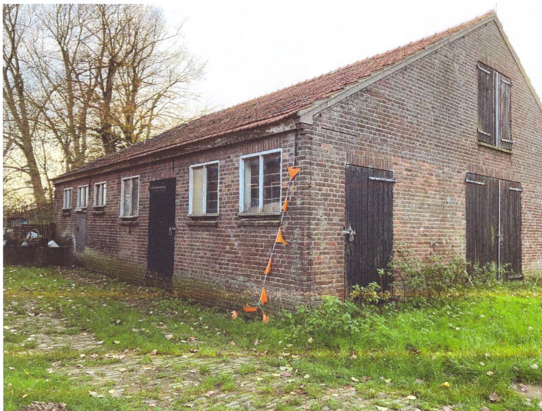
De linker zijgevel van de veeschuur
