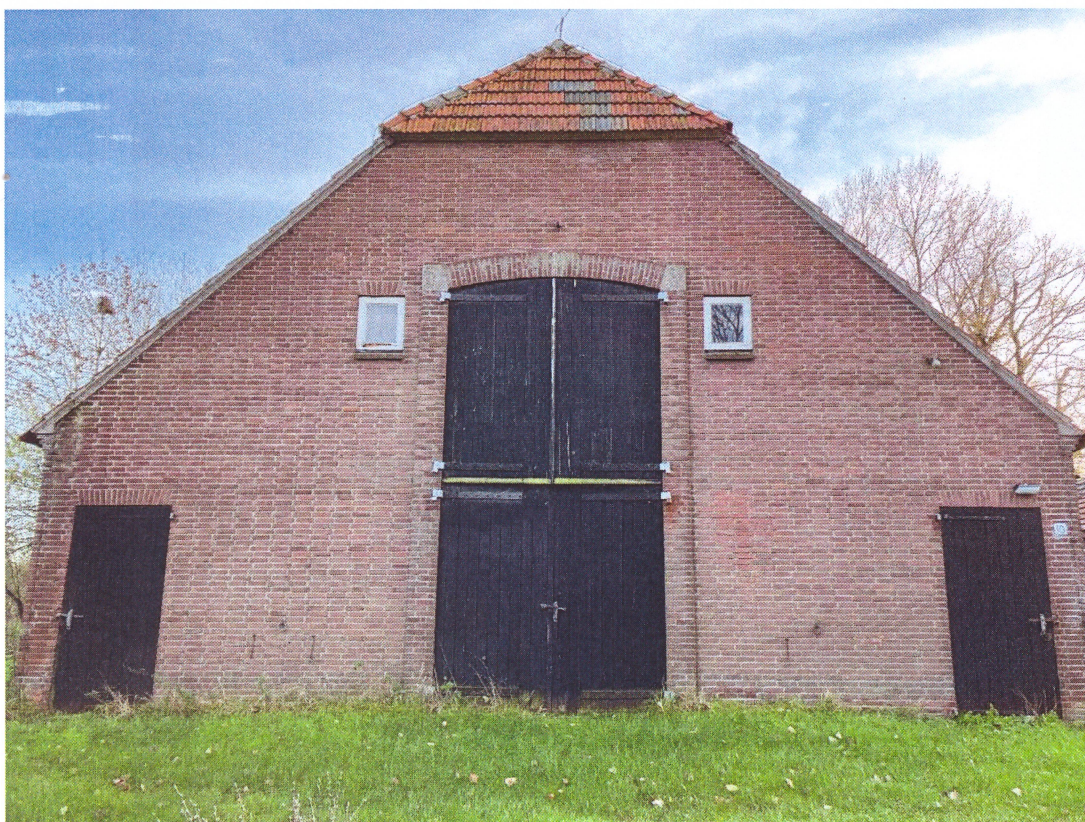
Achtergevel van de boerderij.
